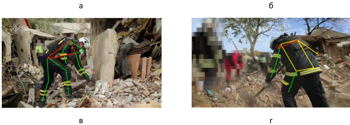
Рисунок 7 – Фото ергономічного дослідження ризиків рятувальників під час виконання аварійно-рятувальних робіт на Харківщині після обстрілу: а – гасіння пожежі; б – ручне розбирання дерев'яних завалів; в – ручне розбирання кам'яних завалів; г – за допомогою лопати
