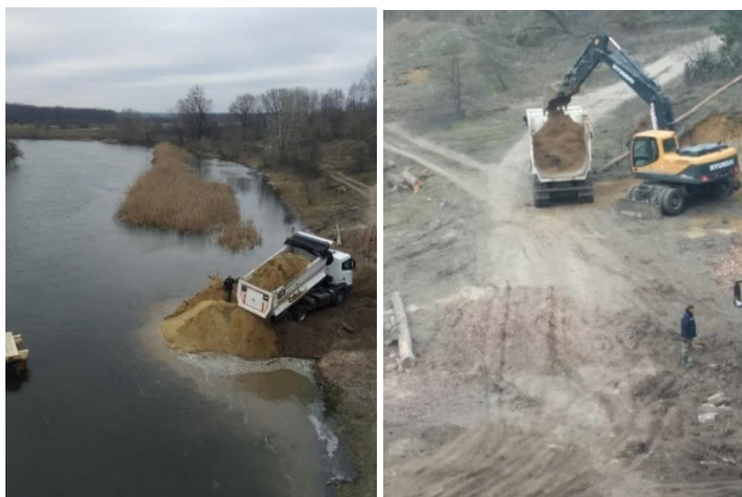
Рисунок 1 – Спорудження насипу підходів до мосту будівництві тимчасового мостового переходу на ближньому обході через річку Сіверський Донець
