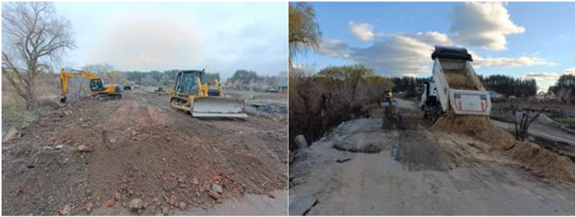
Рисунок 2 – Відсіпка земляного насипу при капітальному ремонті автомобільного мостового переходу через річку Оскіл Харківської області
